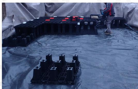
**Il est important de vérifier régulièrement la bonne pose des clés ainsi que la planéité du fond de forme.**
