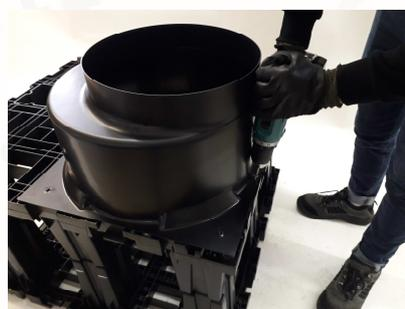
Pour la connexion d'un tuyau de diamètre 315 ou 400 mm, le rajout d'une pièce de connexion est nécessaire. Il faut découper la plaque latérale suivant le gabarit désiré 315 ou 400, puis visser la pièce de connexion sur la plaque. Il suffit ensuite d'insérer le tube dans la pièce de connexion et de l'enfoncer jusqu'à ce qu'il soit en butée sur les chandelles du module.
