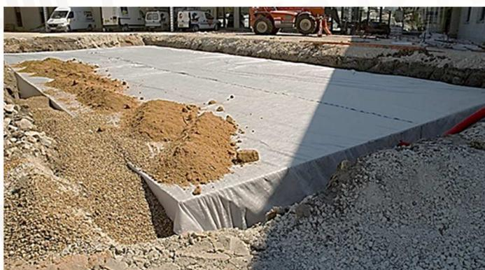
**Une fois le remblai périphérique entièrement terminé, le remblai supérieur devra être déroulé et compacté par couche de 30 à 40 cm jusqu'au niveau souhaité (maximum de 2 m) sur toute la surface du bassin.**
