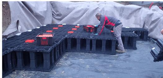
Les cellules SO'BOX sont à raccorder avec des clés clipsables au fur et à mesure de la pose.
